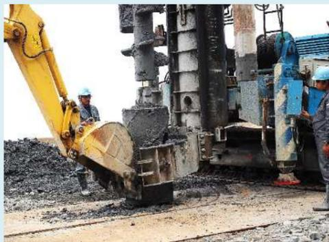
スクリー先端にコアチューブを取り付ける
