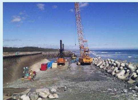
施工ヤードを盛土造成し、MLT工法にて支障物を撤去
