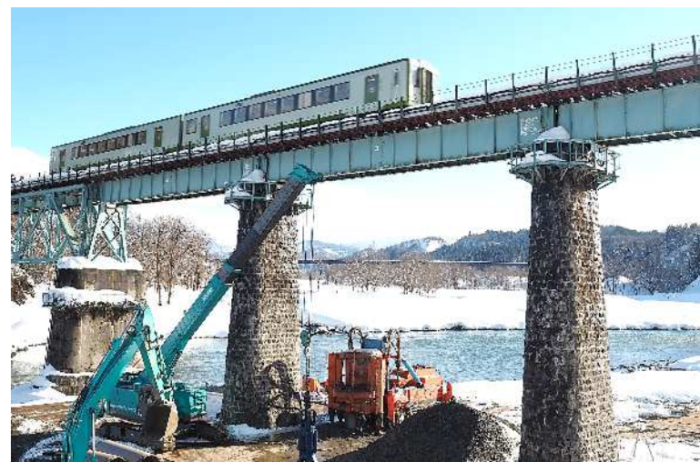
新潟県十日町市 信濃川橋りょう補修工事 置換工(鋼矢板)
