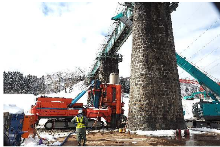
新潟県十日町市 信濃川橋りょう補修工事 置換工(鋼矢板)
