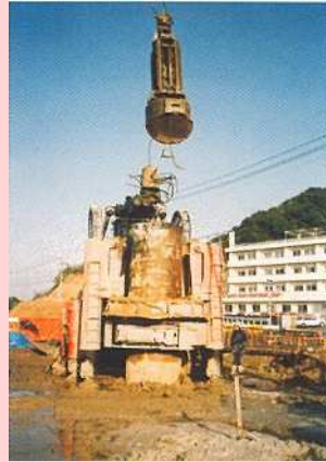
地中支障物撤去
