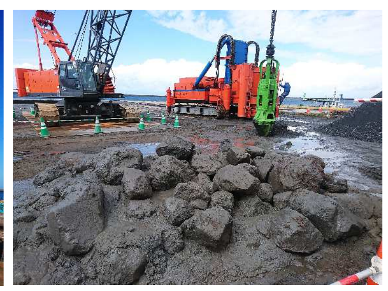
山形県酒田市 酒田北港 護岸捨石撤去(鋼管杭)
