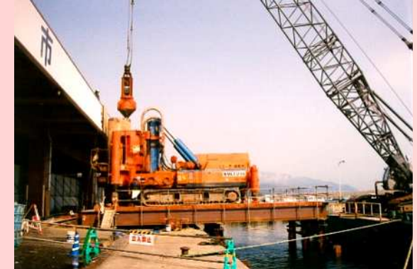
漁港内での場所打杭施工
